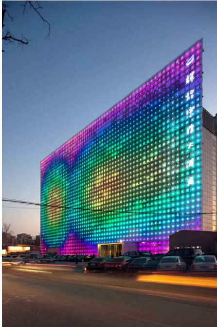
Detalle de aplicación artística de DID en fachada de edificio.
